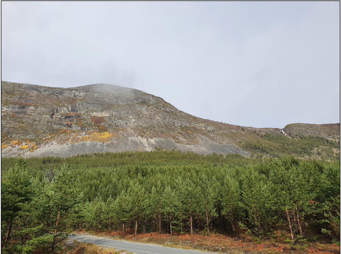
Figur 5: Bilde som viser den aktuelle fjellsiden.
