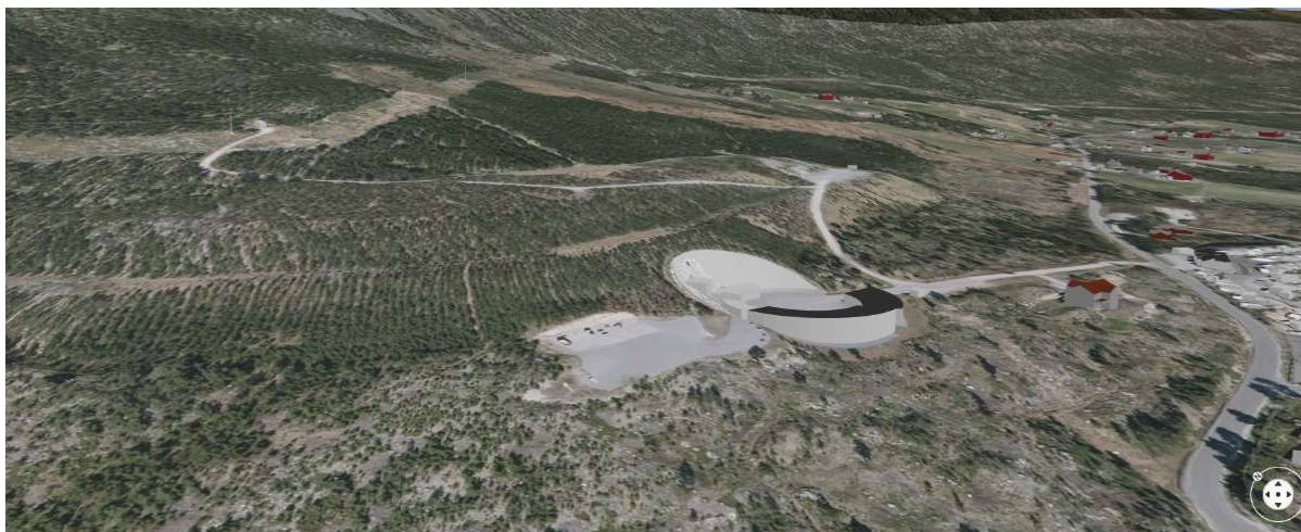
Figur 4. Øyberget kraftverk med massetippen i bakgrunnen. Fylkesvegen ses lengst til høyre i bilde.
