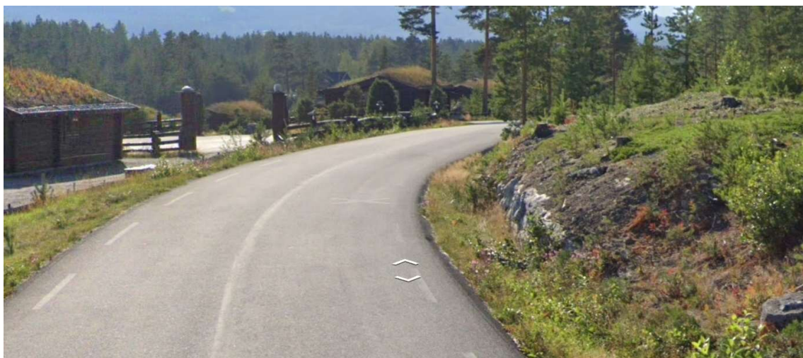
Bilde 1: Det er avgrensa sikt mot innkøyrsla mot campingplassen for køyrande langs fylkesvegen frå aust. Det vil vere vanskeleg å sjå fotgjengarar som vil krysse vegen frå nord til sør (høgre mot venstre i bildet) om overgangen blir lagt aust for innkøyrsla – sjølv om forholda vil bli noko betre senking av terrenget ved bygginga av gang- og sykkelvegen (på høgre hand). Foto: Statens Vegvesen.
