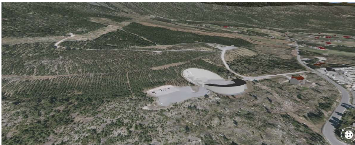
Figur 4. Øyberget kraftverk med massetippen i bakgrunnen. Fylkesvegen ses lengst til høyre i bilde.
