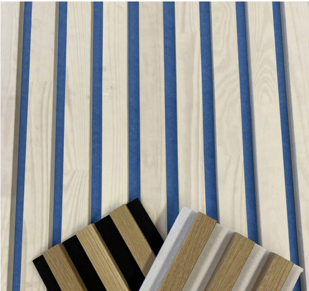
Figur 7 Lilla markering angir anbefalt plassering av veggabsorbenter
